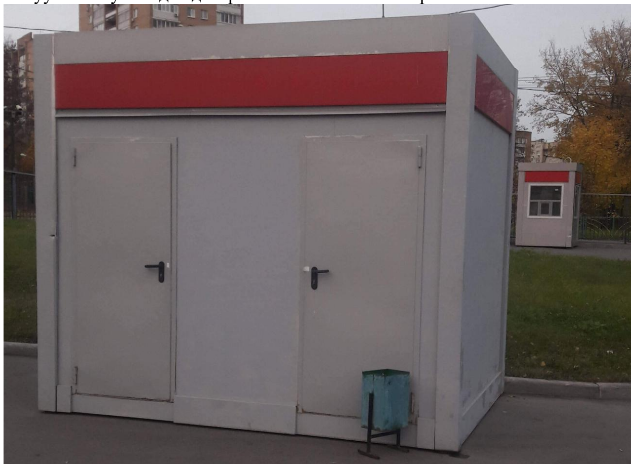
Вакуумный туалет для департамента капитального ремонта на ТПУ
